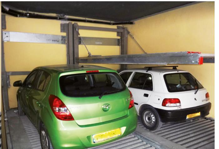
Zwei Einzelanlagen: Eine abgesenkten und eine gehobene Anlage.
